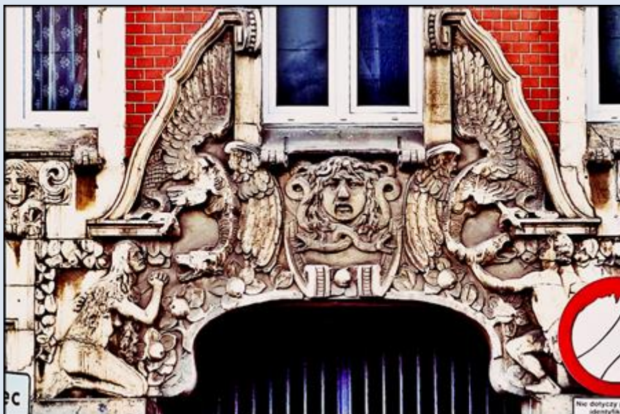
Bytom, na fasadzie budynku przy ul. Powstańców Warszawskich (zdj. pw)
