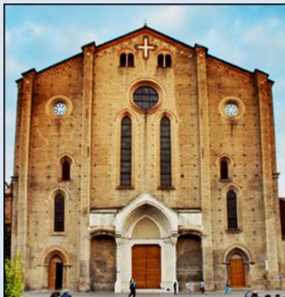
wejście główne od strony Placu św. Franciszka
