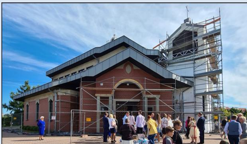
remont w dniu fotografowania 5.09.2021 r.
