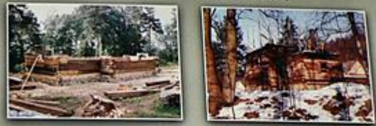
Budowa cerkwi w skansenie (1996-2001)
