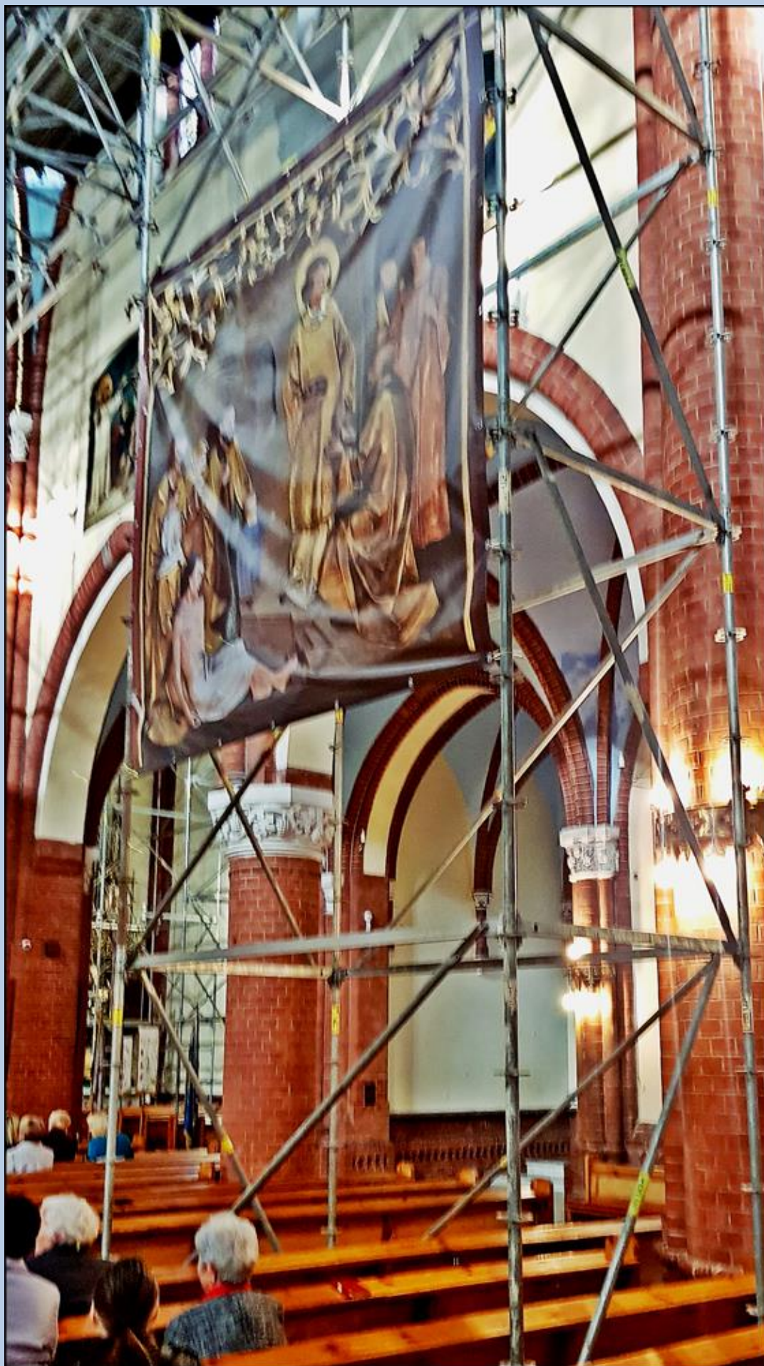
zdjęcie z 10 czerwca 2019, gdy trwał remont kościoła
