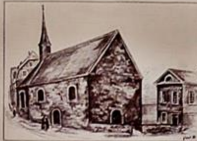
Erste Antoniuskirche, erbaut 1708-1711, bis 1824 genutzt, dann zum Wohnhaus umgebaut
