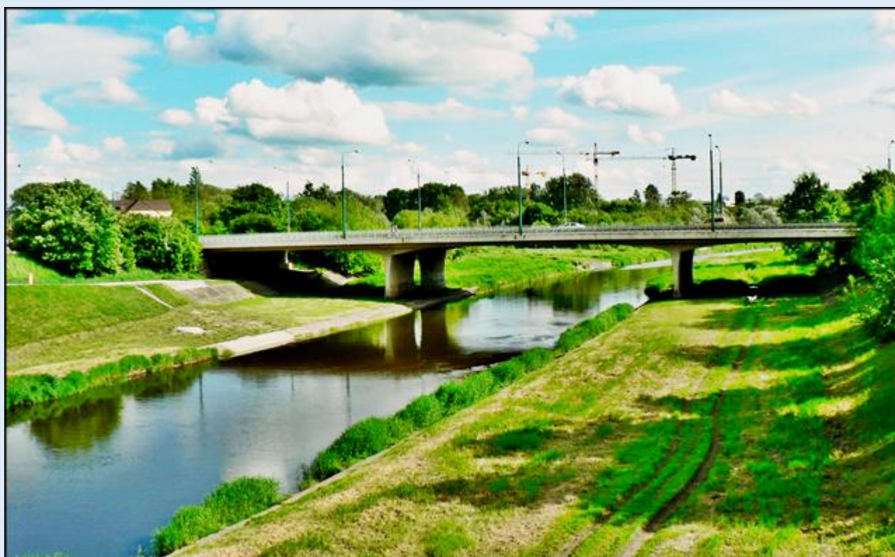
widok z Mostu Jordana na most kolejowy
