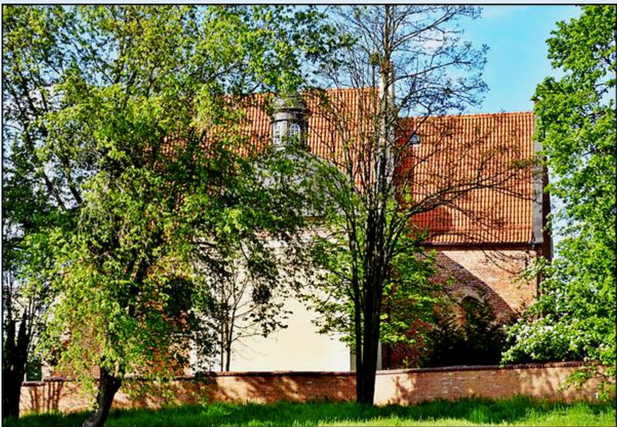
Kościół pw. św. Jana Jerozolimskiego za Murami
