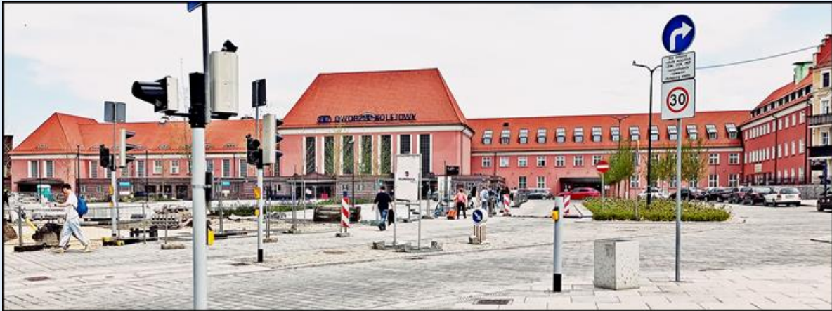
Dworzec PKP Głiwice – otwarty 2 października 1845 r. (obecnie plac w remoncie – 16.02.2023)
