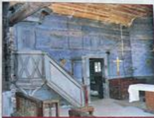
Widok prezbiterium przed i po konserwacji
